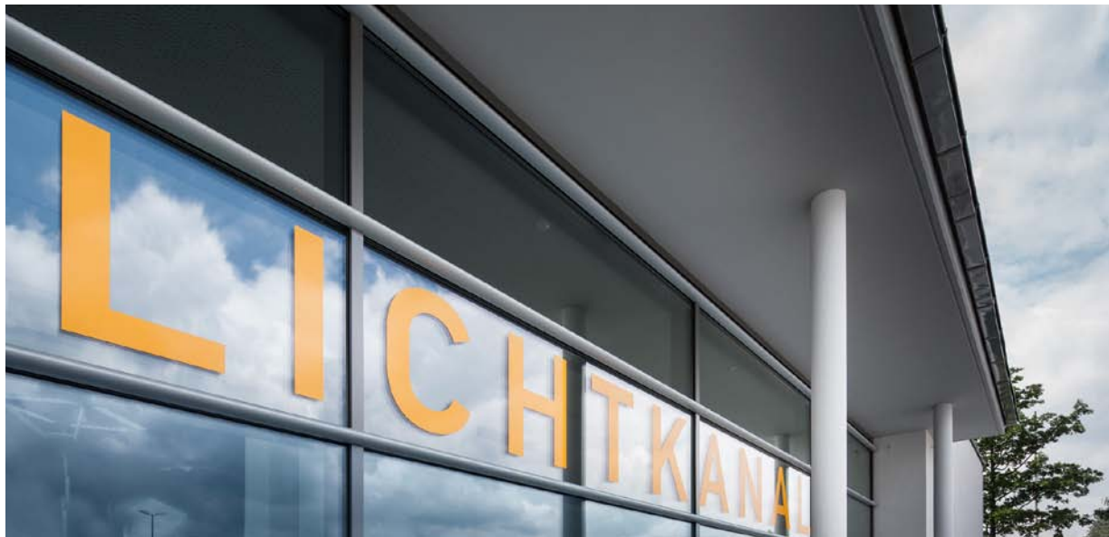
Im 140 Meter langen Lichtkanal vermessen und testen HELLA Ingenieure innovative Scheinwerfertechnologien und Lichtquellen
