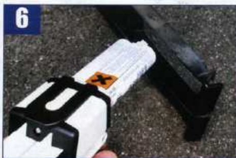
6 Je nach Einbausituation werden die Leuchten ent-weder mit 2K-Polyurethan verklebt oder ...
