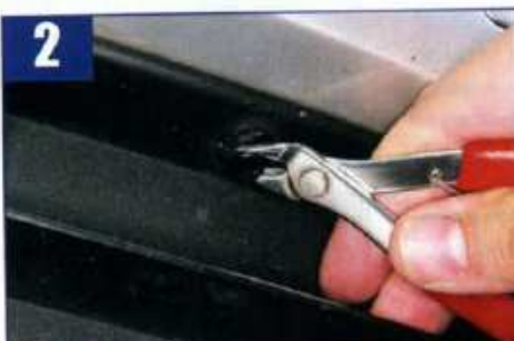
Kunststoff-Pilze an Luftgittern heraus ziehen, anschließend Spreizdübel entfernen
